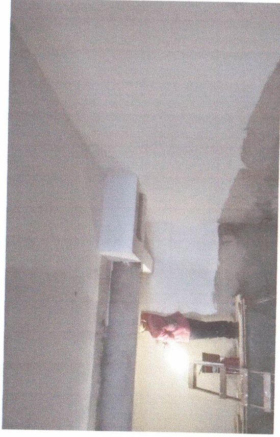
Vista Emassamento Paredes
