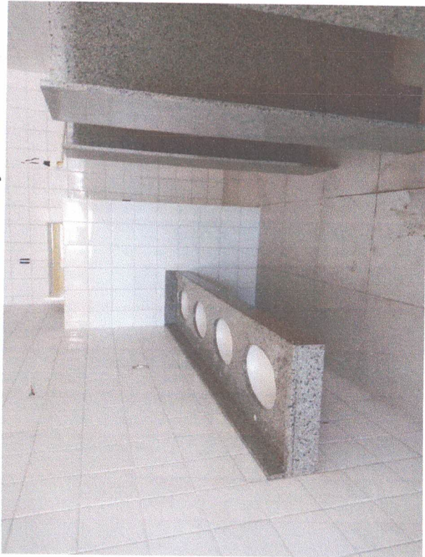
Divisória Granito / Azulejo Branco / Instalações Hidráulicas
