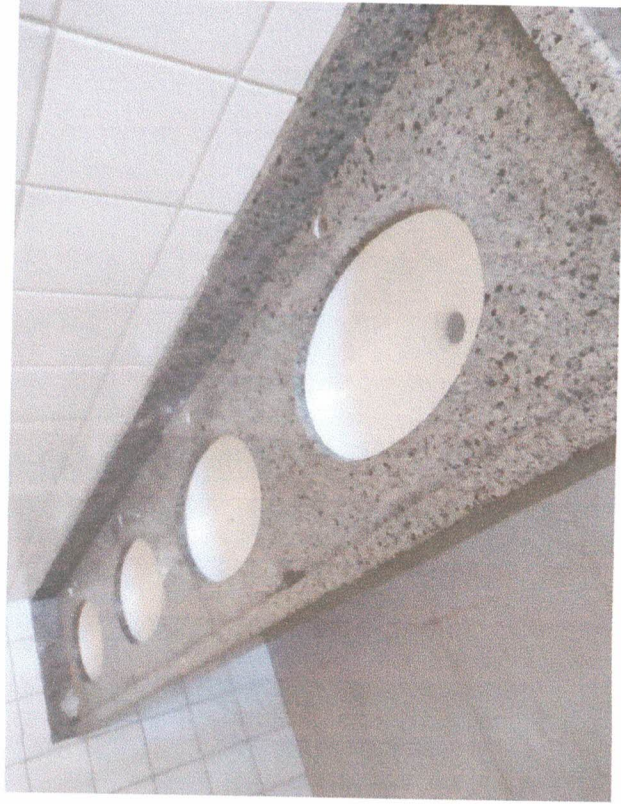
Bancada Granito / Cubas em Louça / Rodabanca granito
