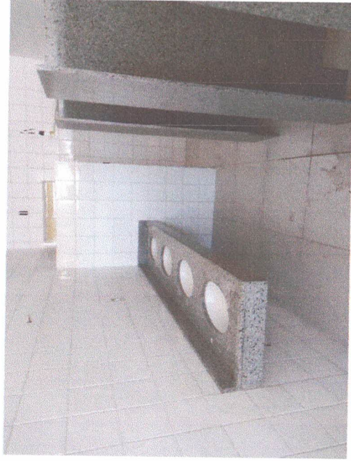
Bancada Granito / Cubas em Louça / Rodabanca granito
