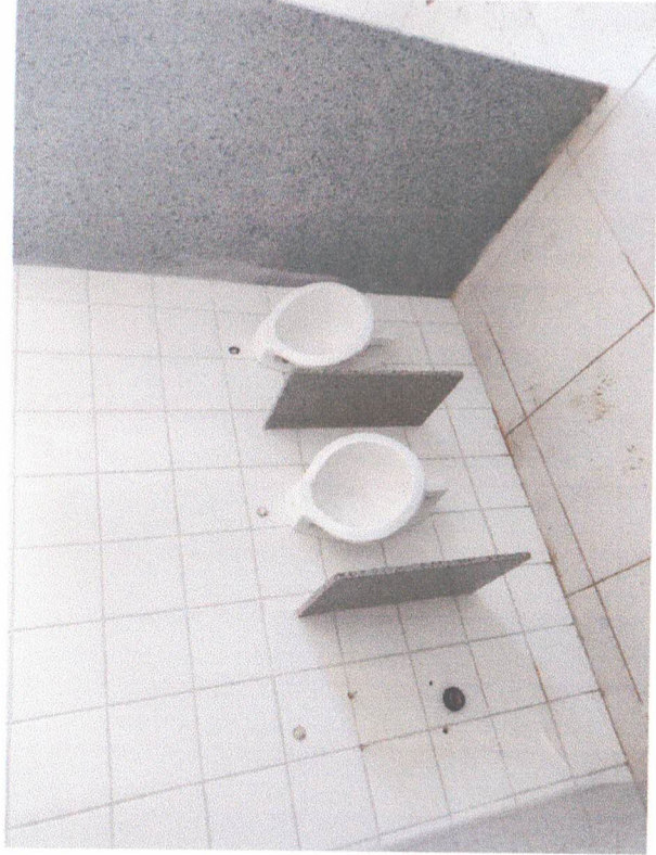
Divisória Granito /Azulejo Branco/Instalações Hidráulicas
