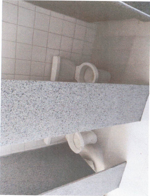
Divisória Granito / Azulejo Branco / Instalações Hidráulicas
